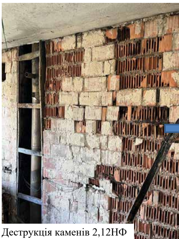
Рис. 2. Пошкодження цегляної кладки стін будинку
