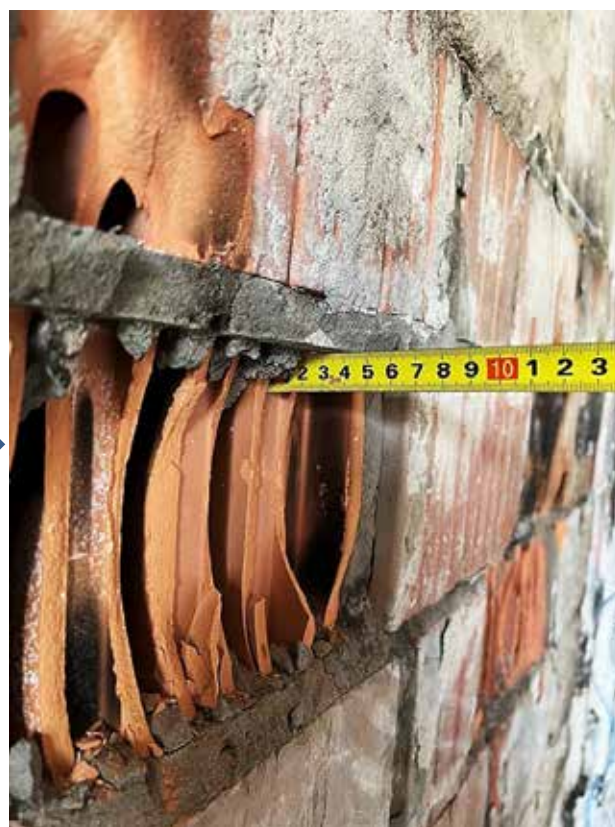
Рис. 2. Пошкодження цегляної кладки стін будинку
